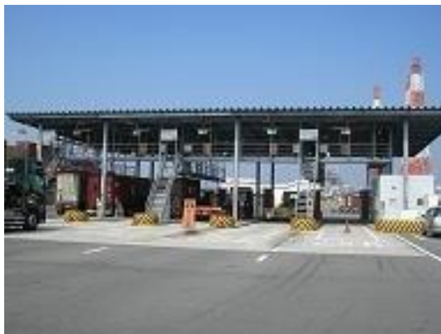
図1-1 飛島コンテナターミナル・インゲート
