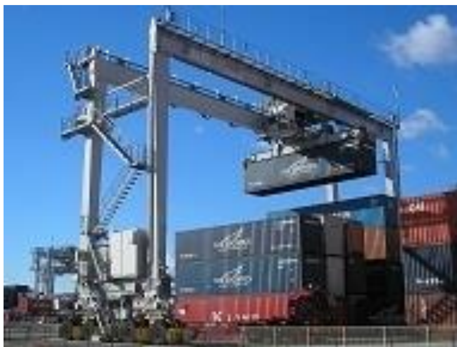
図 1 - 3 飛島コンテナターミナル・自動化 RTG
